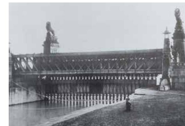
Zu den vielen Besonderheiten der Anlage zählt zweifellos auch die Schemerlbrücke, die, wie die gesamte Anlage, von 1894 bis 1898 errichtet wurde. Mit ihren knapp 50 Metern überspannt sie neben dem Kanal auch den neun Meter breiten dazugehörigen Treppelweg. Die Fachwerkkonstruktion erfüllt dabei nicht nur eine klassische Brückenfunktion, sondern war sowohl statisch als auch betriebstechnisch als
