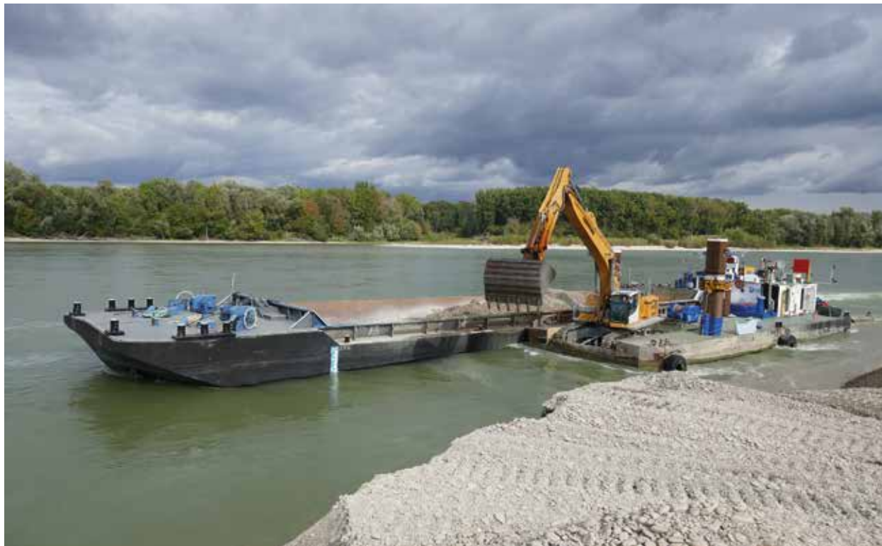
Baggern mit Gefühl. Durch die Neugestaltung des Donauufers an der Fischamündung entstand ein neues Flussbiotop.
