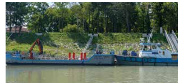
Ebenso Thema bei der Bau- und Schifffahrtsbesprechung: Mit dem zweiten Bojenleger gibt's bald noch mehr Power für die Sicherheit der Wasserstraße.
