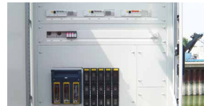
Ein wichtiges Anliegen von viadonau und dem Bundesministerium für Klimaschutz: die Elektrifizierung des Schiffsbetriebs an Liegestellen.
