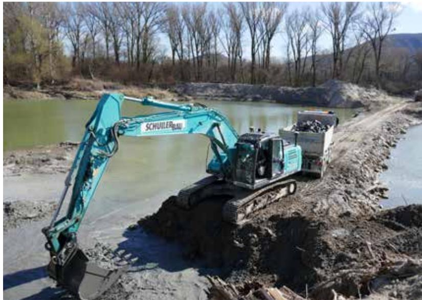
Durch Tieferlegung der Einströmöffnung und Rückbau von Traversen entsteht ein vier Kilometer langes durchströmtes Nebengewässer.
