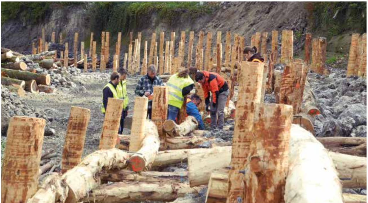
Am Johler Arm wird eine naturnahe Ufersicherung errichtet.
