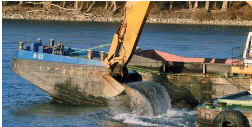
An charakteristischen Stellen wurde in der Wachau Flusssediment gebaggert, um spezifische Korndurchmesser zu ermitteln.
