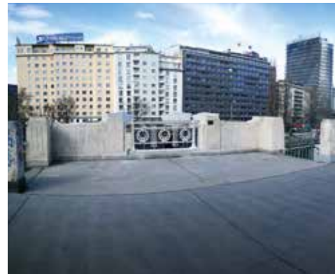
27 Ausgegraben Gepflegtes Erbe der Belle Époque
