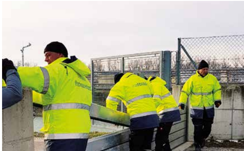
In einer Krise ist schnelles Handeln gefragt – wie beim Aufbau einer mobilen Hochwasserschutzwand.
