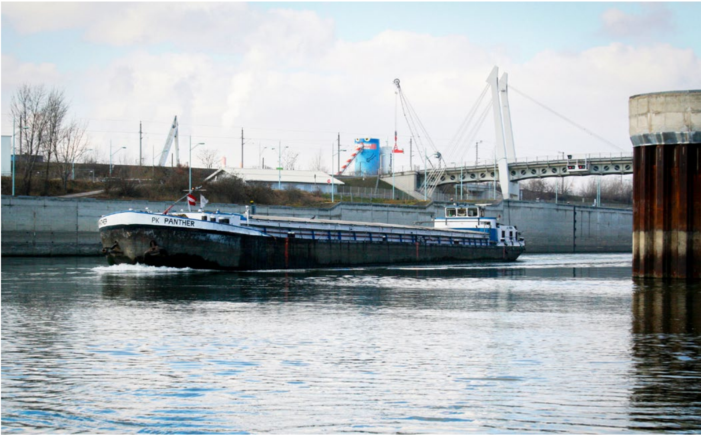
Auch die verstärkte Einbindung „beweglicher Infrastruktur“, z. B. Schleusen, in digitale Informationsnetzwerke steht im Fokus.
