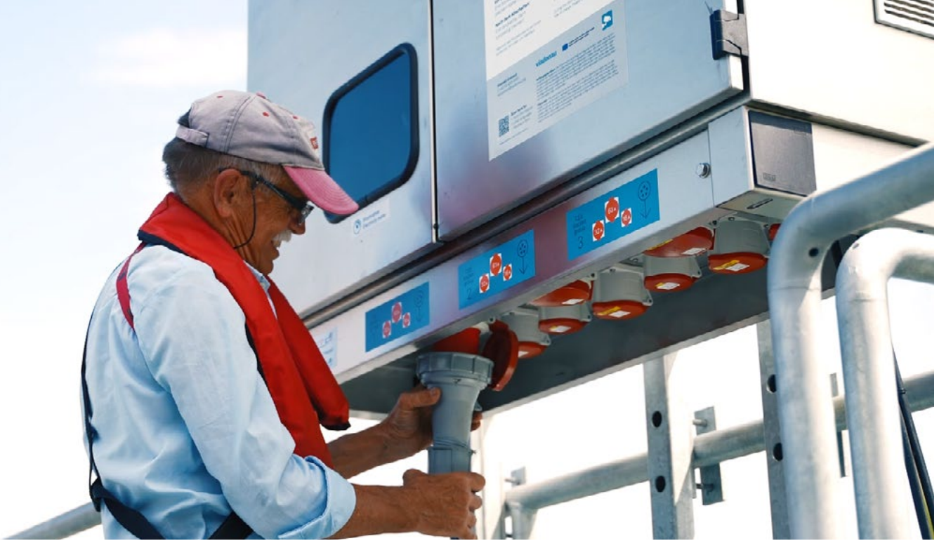
Dank Landstromversorgung werden Dieselgeneratoren während der Liegezeit überflüssig.
