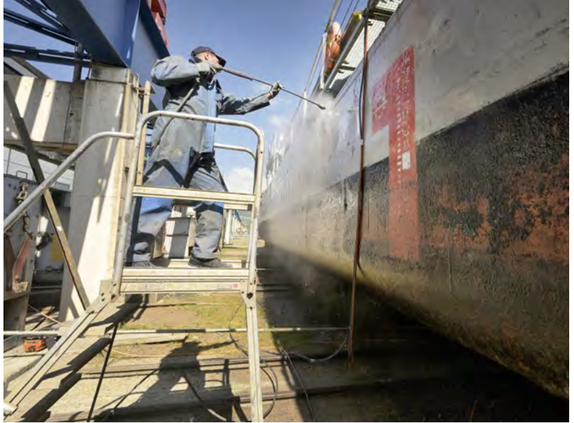
MS Negrelli im Rundum-Service: Konservierung der Unterkonstruktion, Instandsetzung des Antriebs, Reinigung des Rumpfes und Einbau der Aufzuchtbecken
