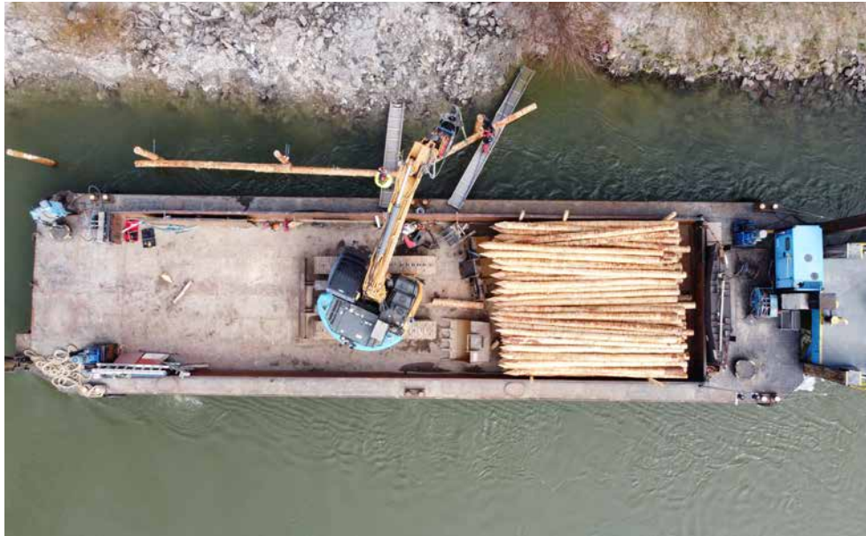
Holzpiloten bilden die buchstäblichen Säulen des ingenieurblogisch gesicherten Uferabschnitts.
