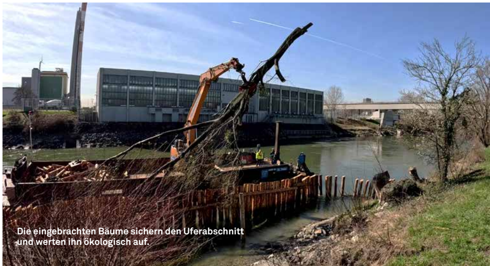
Holzpiloten bilden die buchstäblichen Säulen des ingenieurblogisch gesicherten Uferabschnitts.
