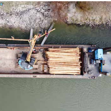
14 Umwelt Ingenieurbilogische Ufersicherung am Donaukanal
