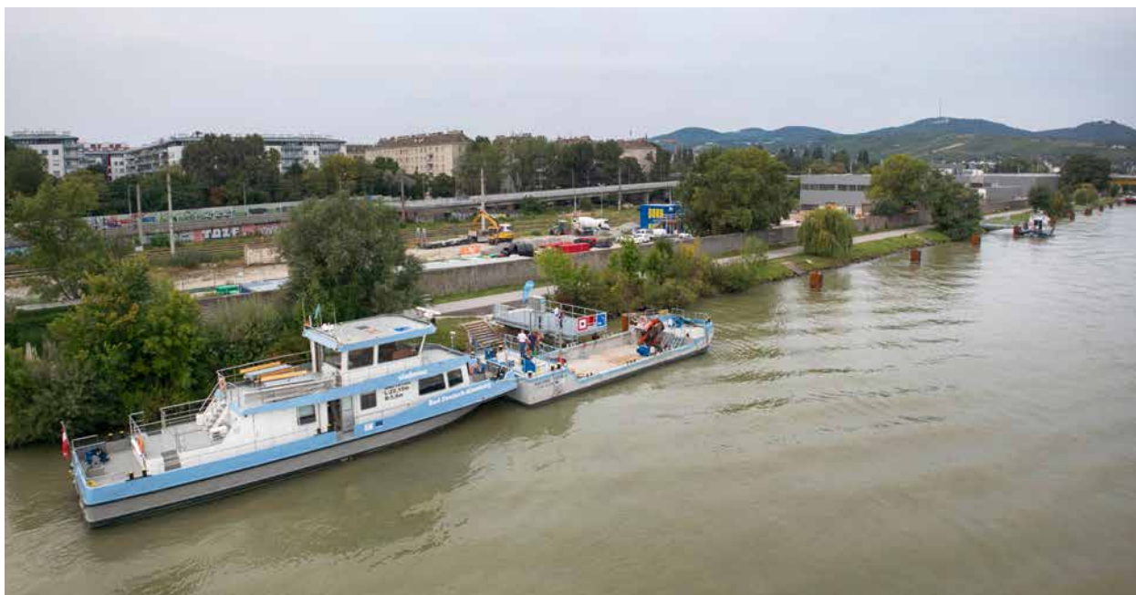
Die modernisierte Lände Brigittenau II in Wien bietet hohe Sicherheit und nachhaltige Energieversorgung für Güterschiffe.
