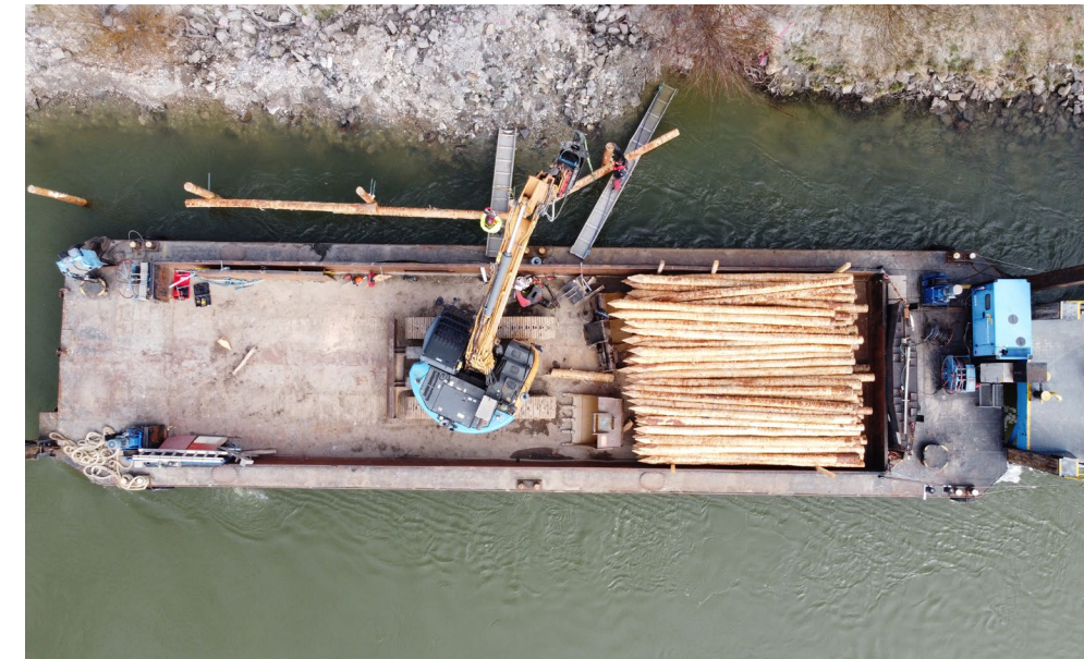
Holzpiloten bilden die buchstäblichen Säulen des ingenieurbilogisch gesicherten Uferabschnitts.
