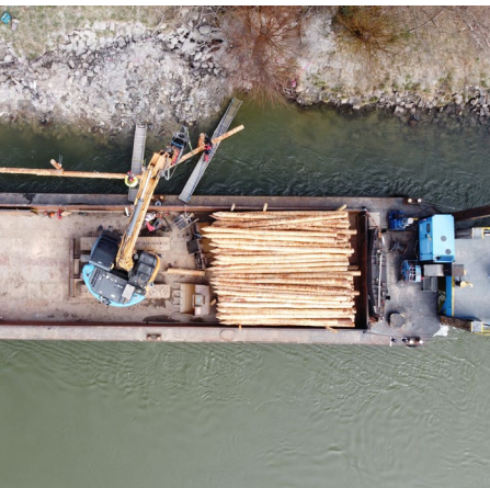
14 Umwelt Ingenieurblogische Ufersicherung am Donaukanal
