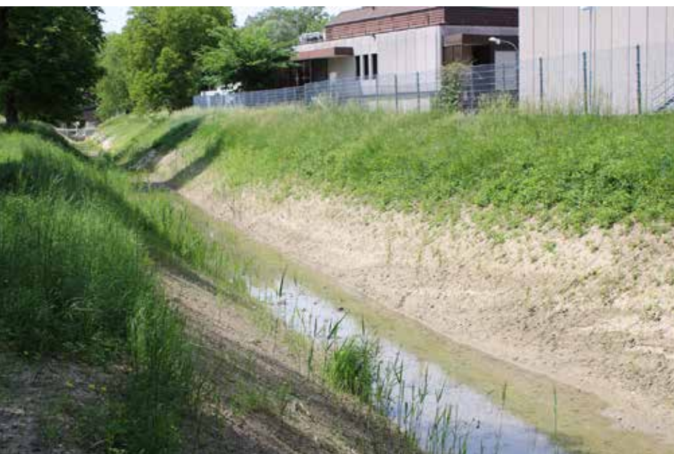
Unscheinbar, aber wirkungsvoll optimiert – die eingetiefte Fadenbach-Künette
