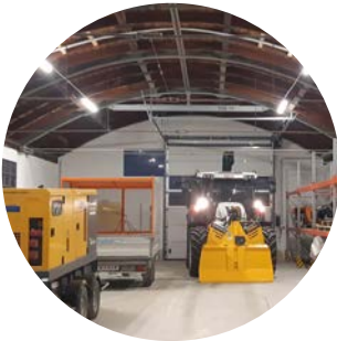
Sanierung der Bauhalle in Bad Deutsch-Altenburg
