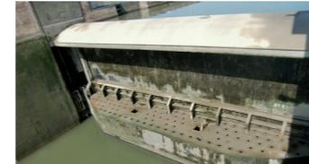
**Unterhaupt** Torkonstruktion am stromabwärtigen Ende der Schleuse
