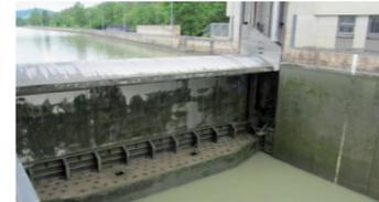
**Unterhaupt** Torkonstruktion am stromabwärtigen Ende der Schleuse
