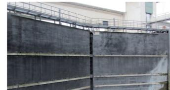
**Stemmtor** Schleusentor im Unterhaupt – Öffnung durch Aufschwenken
