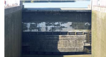
**Unterhaupt** Torkonstruktion am stromabwärtigen Ende der Schleuse
