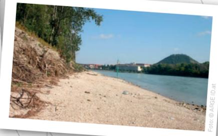
mehr Raum, wodurch die Beanspruchung der Stromsohle verringert und der Wasserspiegel bei Hochwasser gesenkt wird. Mögliche Konflikte mit Hochwasserschutz, Schifffahrt, Siedlungsgebieten und technischer Infrastruktur werden berücksichtigt.
