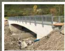
**Erweiterung der Rührsdorfer Brücke**, um die Durchströmung zu verbessern. Verbreiterung auf 20 m lichte Weite und Anhebung auf 5 m über Niederwasser.
