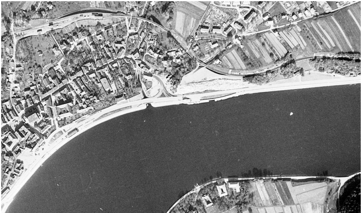
Abbildung 7: Der Bereich des ehemaligen Schwalllecks im Jahr 1959 ein Jahr nach dessen Sprengung. Der abgesprengte, noch unbewachsene Felshang sowie die neu errichtete Bundesstraße sind gut erkennbar. (BEV i.A. DoKW AG)
