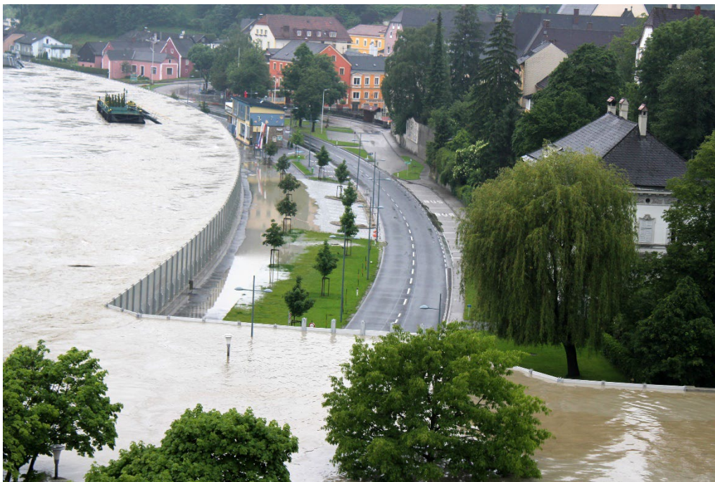
Abbildung 11: Vorausschauende Planung: Das Hochwasser im Juni 2013 erreichte fast auf den Zentimeter genau die Höhe des im Jahr zuvor fertiggestellten mobilen Hochwasserschutzes in Grein (Foto aufgenommen kurz vor dem Höchststand des Hochwassers). (M. Fröschl, Grein)
