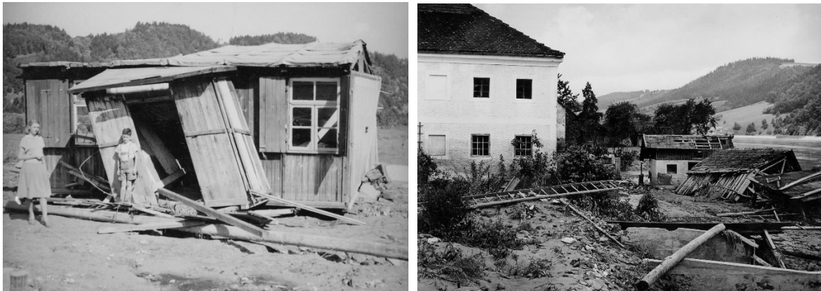
Abbildung 27: Zerstörungen bei Aschach an der Donau und im Bereich von Jochenstein. (viadonau)
