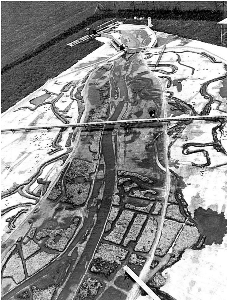
Abbildung 34: Wasserbaulicher Modellversuch für den Bau von „Binnendämmen“ im östlichen Machland 1967. Blickrichtung von Wallsee fluss- abwärts Richtung Ardagger Markt. (BAW, ÖStA/AdR)
