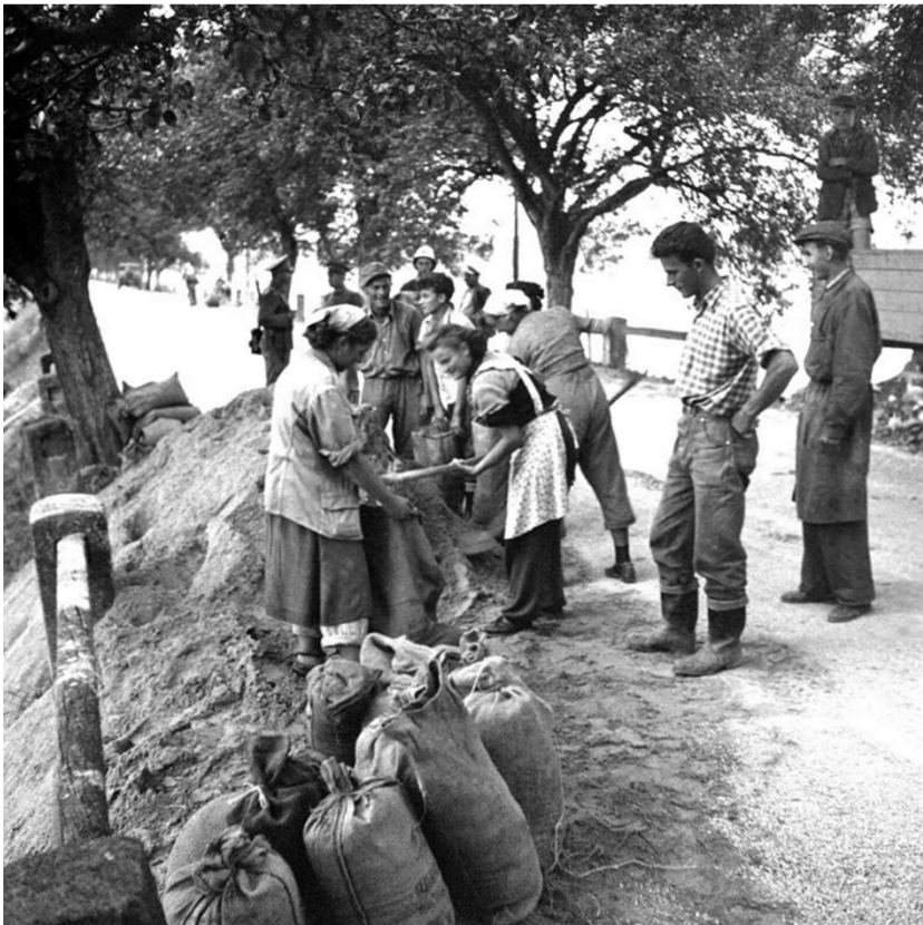
Abbildung 24: Die über die Ufer getretenen Donau drohte den Damm der Bundesstraße bei Wolfsthal zu brechen. Die Feuerwehr bereitete Sandsäcke zum Abdichten vor. (ÖNB Bildarchiv, US 12.168/131)
