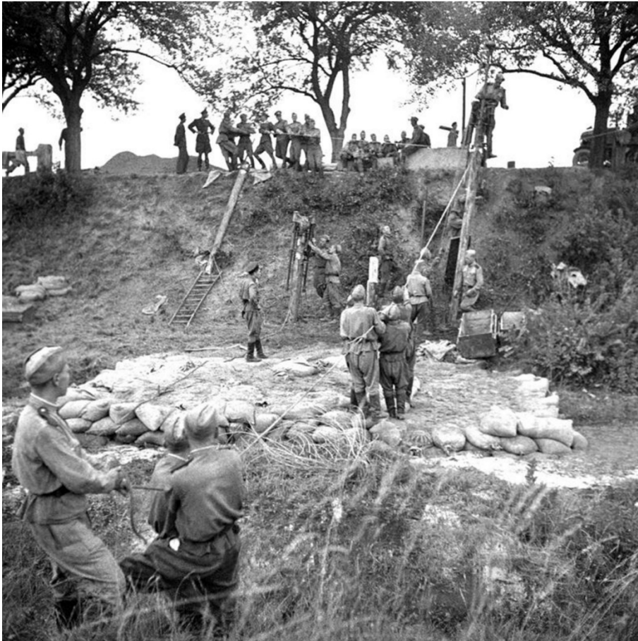
Abbildung 24: Die über die Ufer getretenen Donau drohte den Damm der Bundesstraße bei Wolfsthal zu brechen. Die Feuerwehr bereitete Sandsäcke zum Abdichten vor. (ÖNB Bildarchiv, US 12.168/131)
