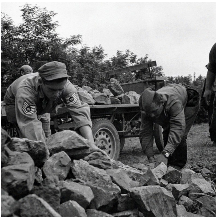
Abbildung 23: Mehr als 5.600 t Bruchsteine wurden zur Dammsicherung vorbereitet. (ÖNB Bildarchiv, US 12.168/93)
