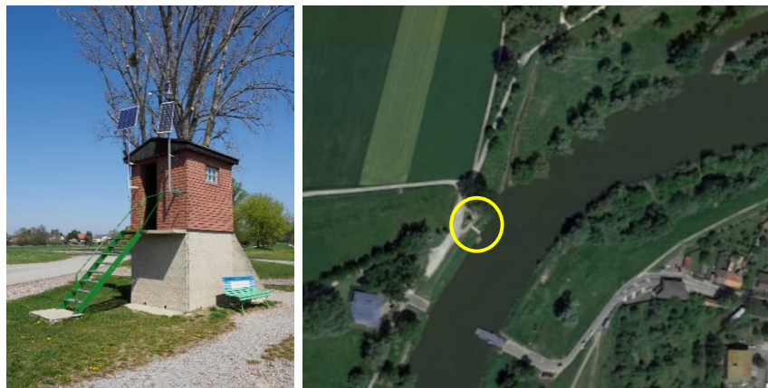
Abbildung 8: Station (gekennzeichnet) unterhalb Ollersbach bzw. oberhalb Fähre Angern
