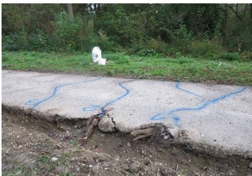
Zusätzlich erhalten zu sanierende Treppelwegbereiche bei der Instandsetzung eine Zementstabilisierung. Dieser geänderte Aufbau des Treppelweges soll die Infrastruktur vor neuerlichen Schäden bewahren. Die detaillierten Erkenntnisse und (Pflege-)Leitfäden wurden aufbereitet, um die Mobilen Services von viadonau in ihren Erhaltungs- und Sanierungsaufgaben optimal zu unterstützen. Das Projekt endete mit Jahresende 2017.
