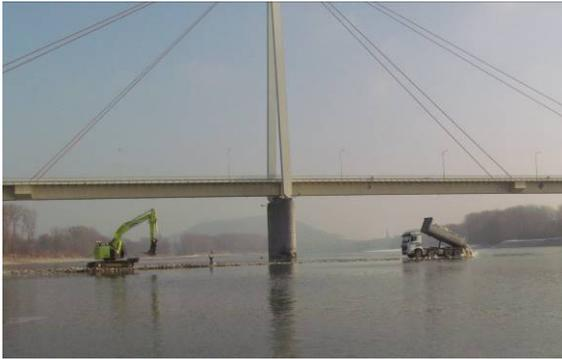
Ziel war die Herstellung der definierten Mindestfahrwasserparameter in der Schifffahrtsrinne (2,50 Meter Fahrwassertiefe bei Regulierungsniederwasser – RNW) sowie die Annäherung an einen Gleichgewichtszustand der Stromsohle zwischen Anlandungen und Sohleintiefung. Bisherigen Untersuchungen zufolge wurde das Projektziel erreicht.
