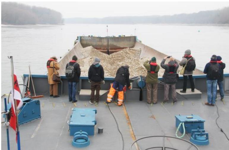
Bild: Eindrücke aus nächster Nähe: Verklappung von Kies zur Stabilisierung der Donausohle im Rahmen des Geschiebemanagements, Foto: © viadonau
