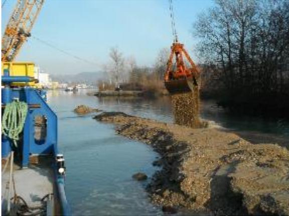
Im Herbst 2019 wurde die Schotterbank Landshaag errichtet. Eine Sanierung der Biotope Zeller Spitz und Ortman (Stauraum Aschach) mittels Kiesschüttungen wurde mit VHP (Verbund Hydropower GmbH) und den Behörden abgestimmt und erfolgte im Dezember 2019.
