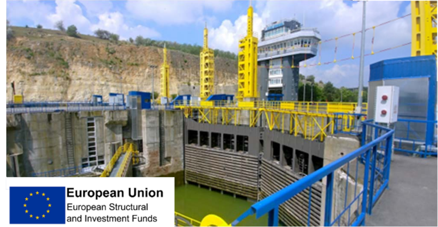
Sanierung der Infrastruktur
