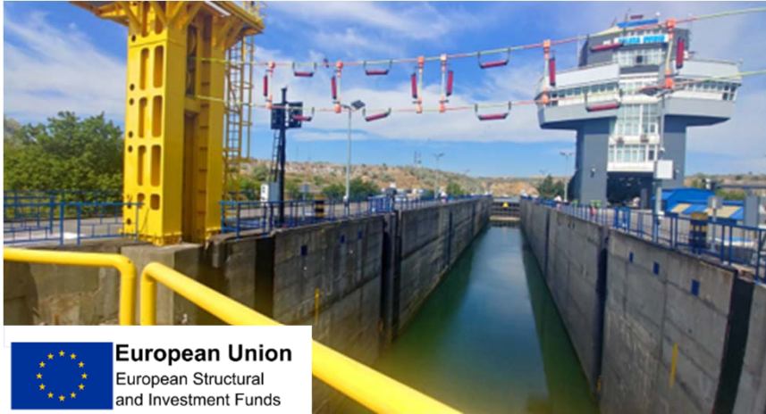
Sanierung der Infrastruktur
