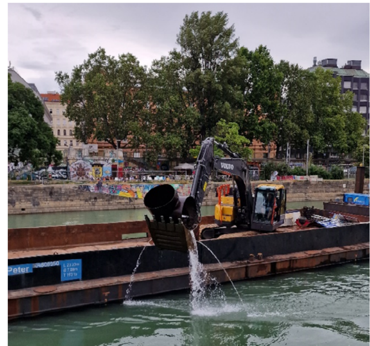
Bergung Stahlrohr (T-Stück) am 13.07.2023
