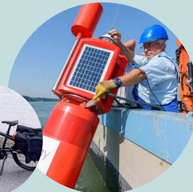
Auch Bojen und Taktfeuer sind mit Solarmodulen ausgestattet.
