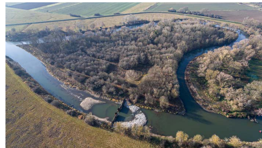
Mäander D18: Ein spezielles Wasserbauwerk sorgt dafür, dass die Staatsgrenze durch die Gewässervernetzung nicht verändert wird.
