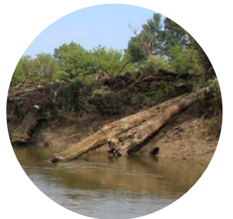
Uferabbruch mit Totholz (March, Lange Luss)
