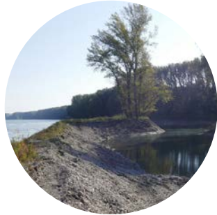
Durch Absenkung entstand ein flacher Seitenarm mit Anbindung an die Fischa.
