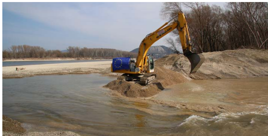
Durchstich – Anbindung des wieder hergestellten Johler Arms an den Hauptstrom
