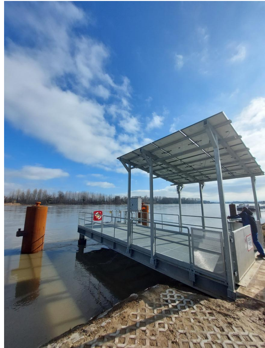
PV-Überdachung PKW-Umsetzbrücken
