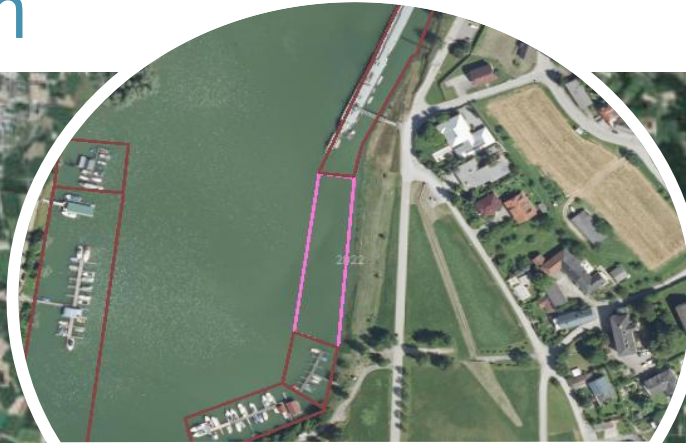
Hochwasserabstellplatz Altarm Wallsee Strom-km 5500,56 – 5500,44 R
