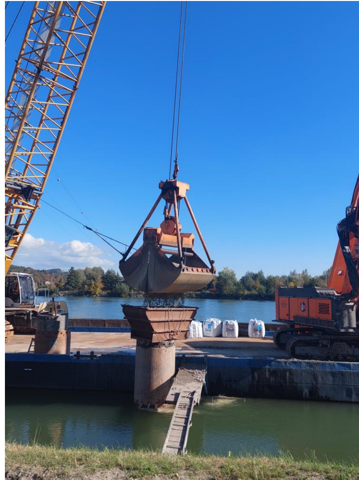
Dalben befüllen nach Rammvorgang
