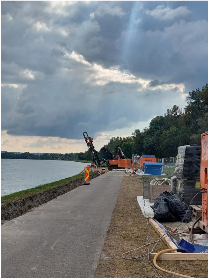
Kabeltrasse Landstromversorgung
