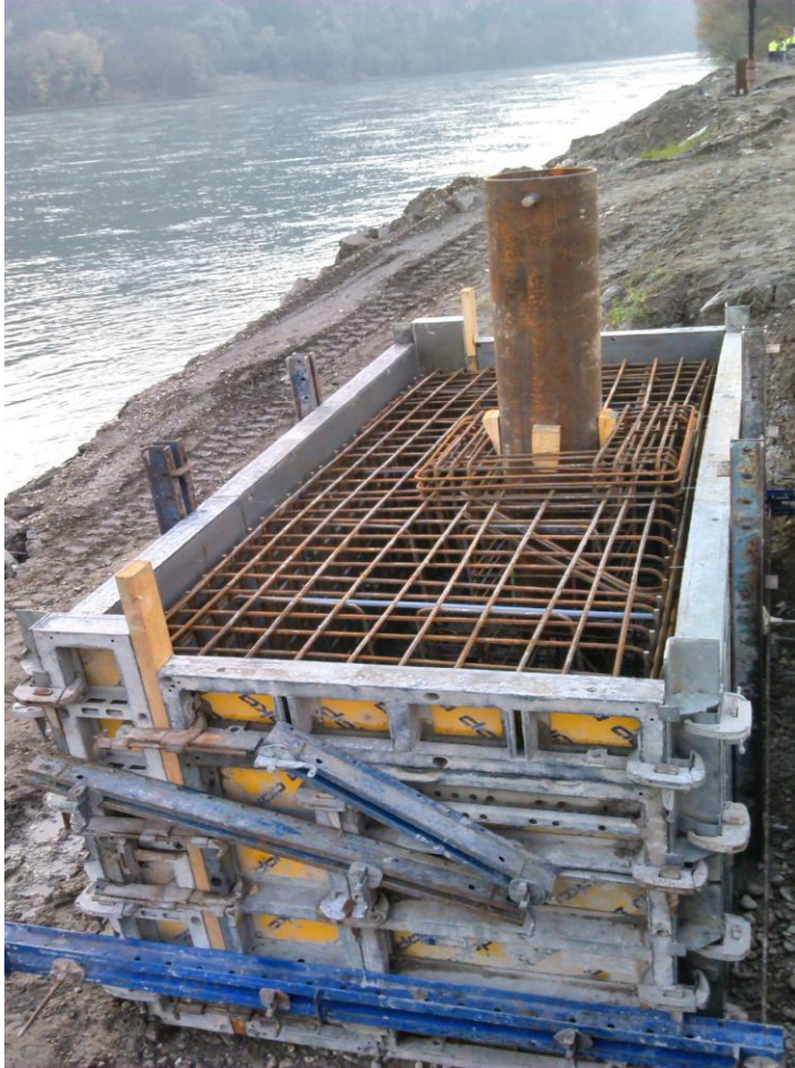
Ertüchtigung/ Erneuerung der Poller
