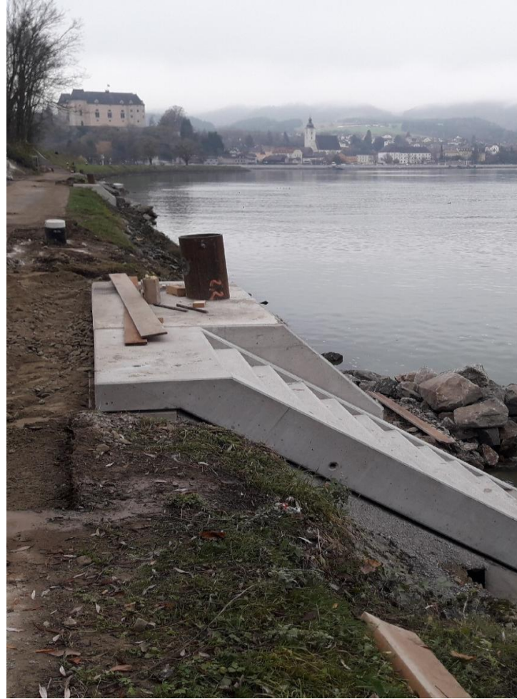
Erneuerung der Stiegen
