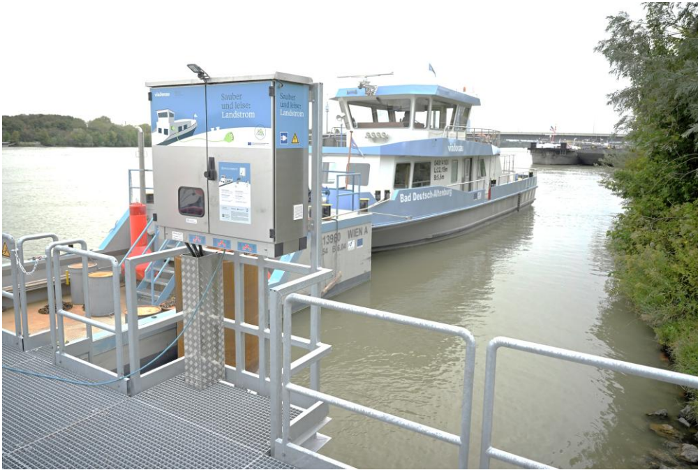
Projektabschlussphase: Landstromversorgung
