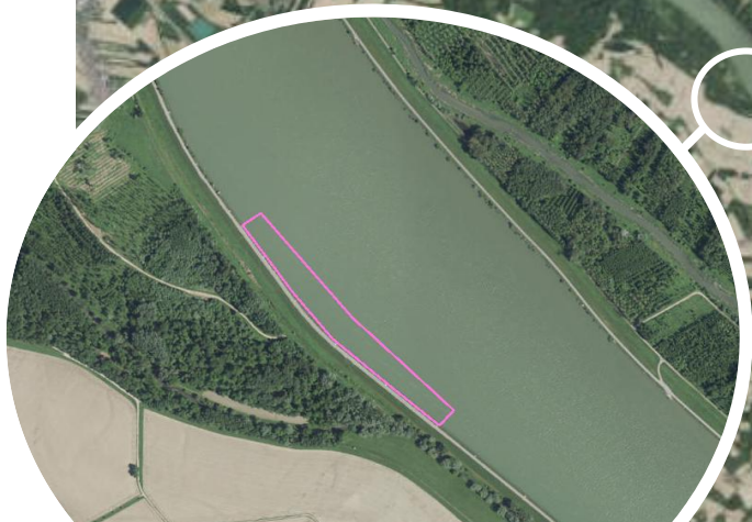
Lände Strengberg-Au Strom-km 2100,77 – 2100,3R
