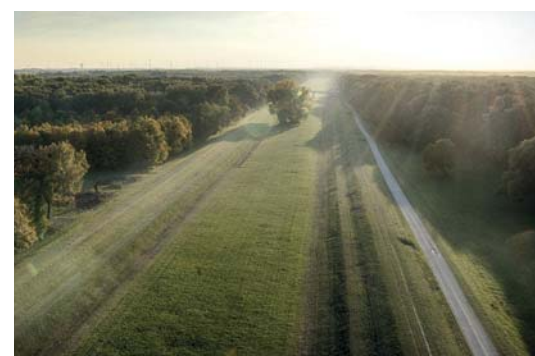
18 Sicherheit Vom alten Damm zum modernen Hochwasserschutz
