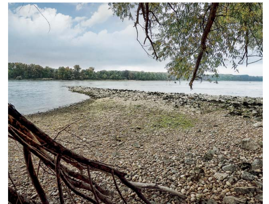
Mit innovativer Neugestaltung von Wasserbauwerken kann Kiesaustrag erheblich gesenkt werden.
