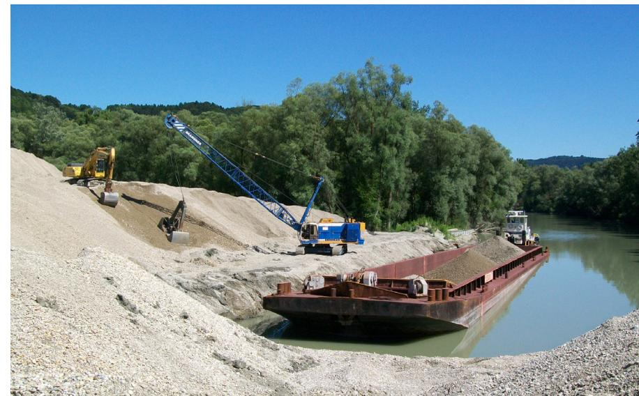
Abtrag und Abtransport des deponierten Kiesmaterials auf dem Wasserweg (etwa 375 Schiffsloadungen)
