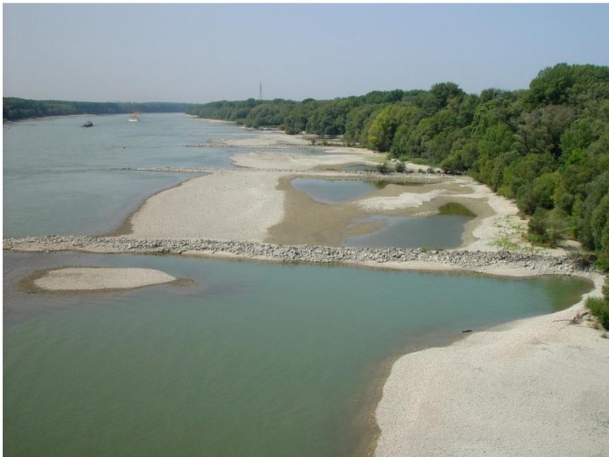
Abbildung 3: linkes Donauufer mit Baggergutablagerungen im Bühnenfeld vor Baumsetzung
