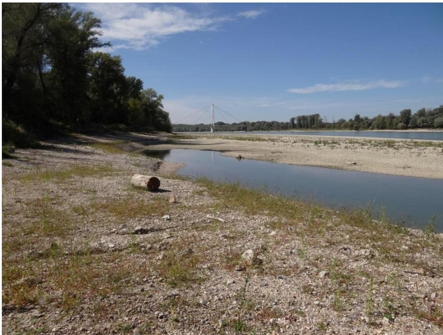
Abbildung 2: kiesiges Ufer des Johler Haufens von km 1885,1 stromauf im Jahr 2015 nach Rückbau des Blockwurfs
