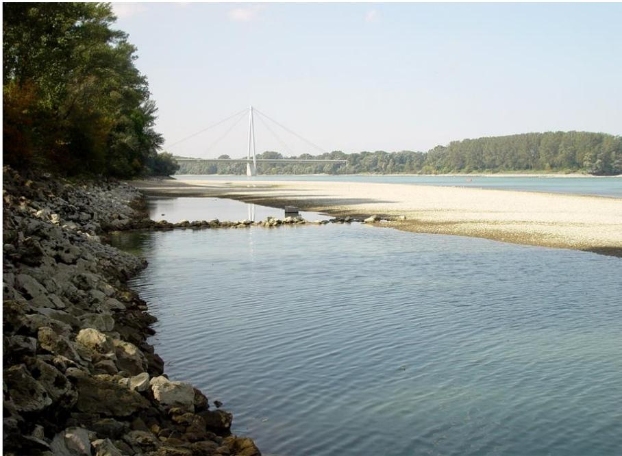
Abbildung 1: Ufer des Johler Haufens von km 1885,1 stromauf im Jahr 2006 (vor Bau) mit massivem Blockwurf
