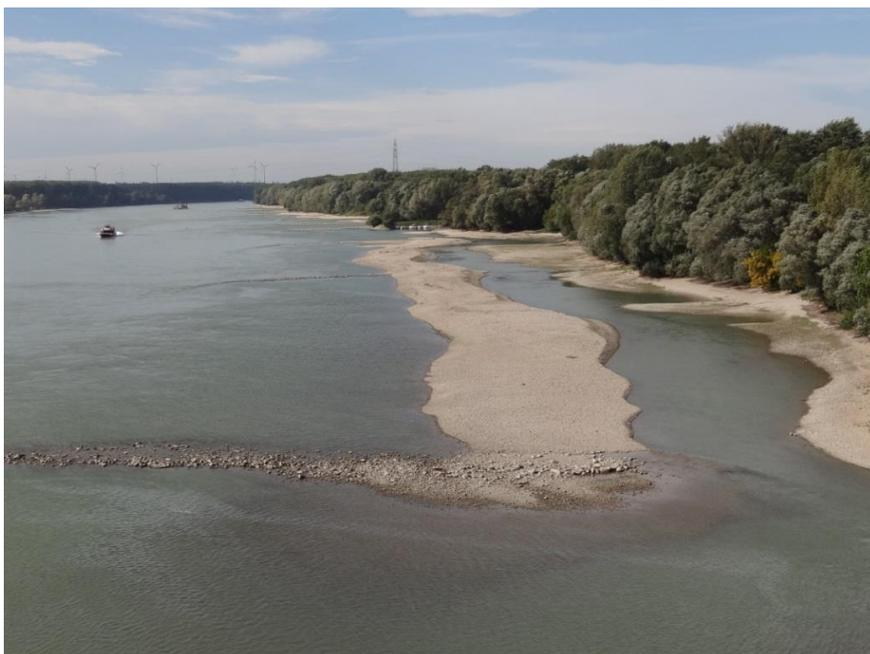
Abbildung 4: linkes Donauufer mit abgesenkten und neu konfigurierten Bühnen sowie neu modellierter linearer Kiesinsel
