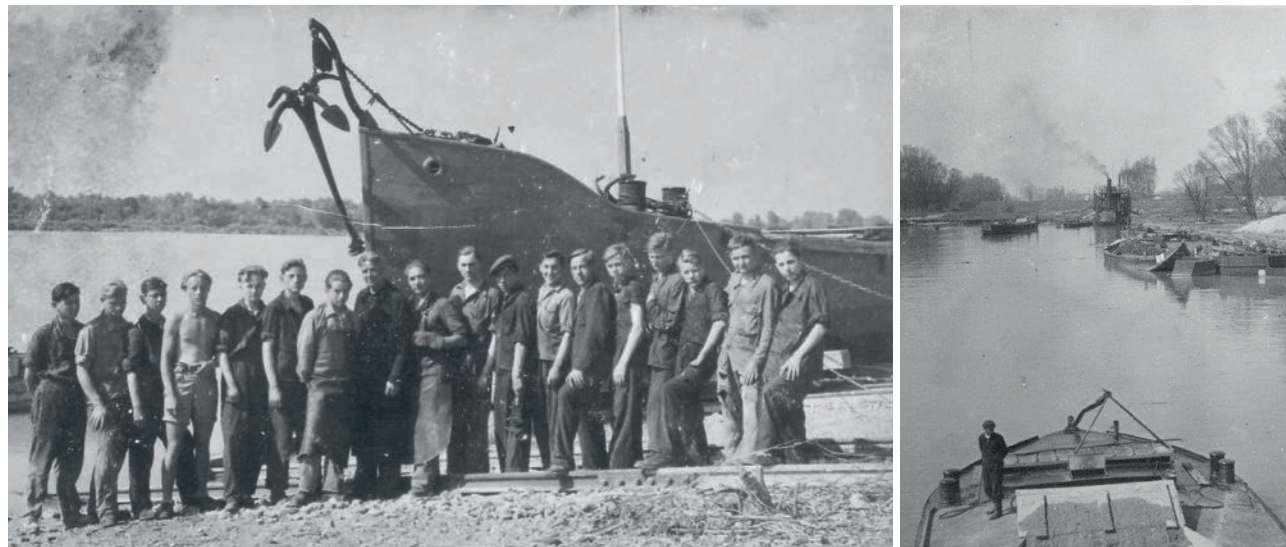
Links: Lehrlinge in Bad Deutsch-Altenburg, ca. 1944; rechts: Bau des Alberner Hafens, 1941 (© viadonau-Archiv)
