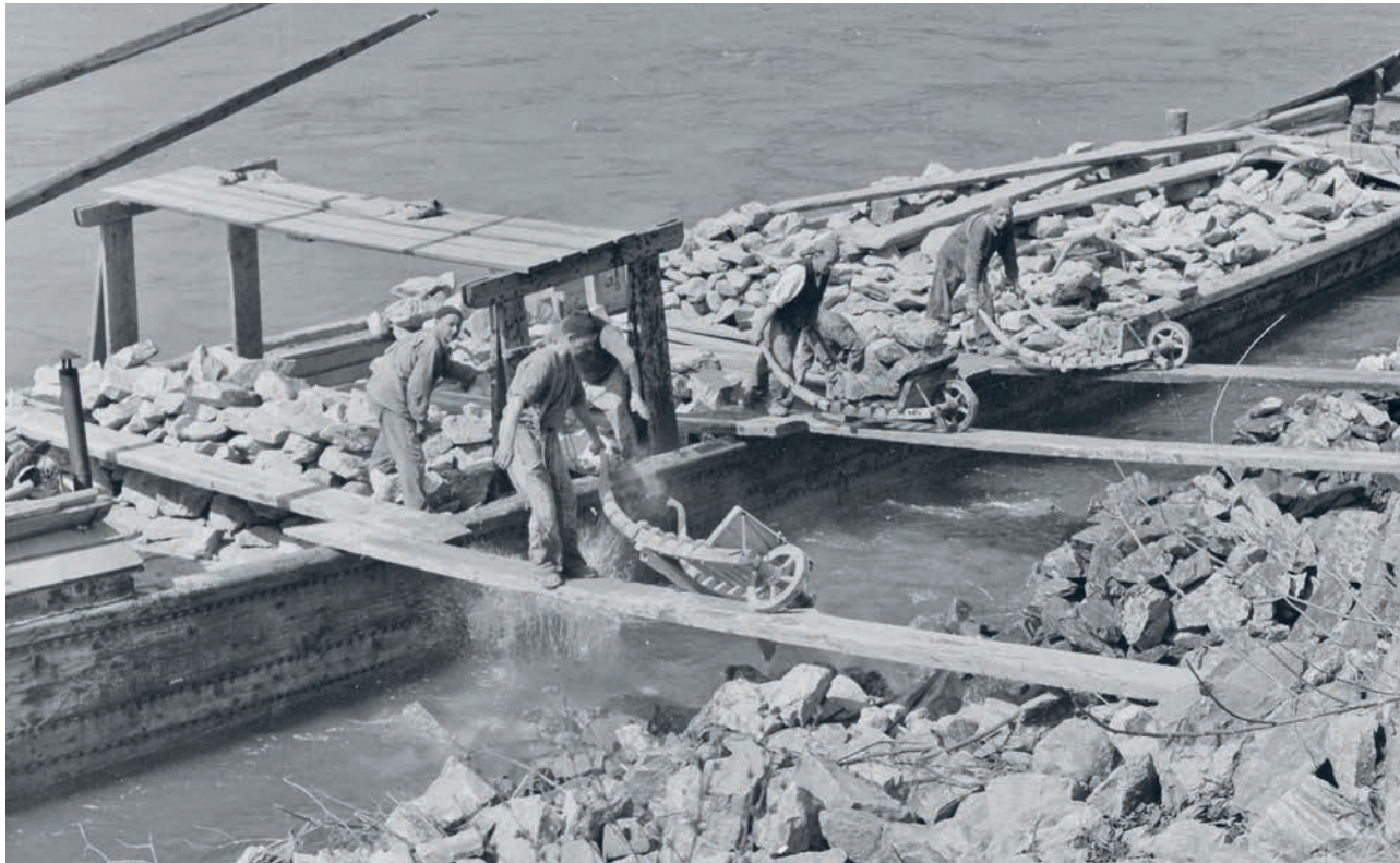
Ufersicherung mit Muskelkraft – Arbeiter entladen aus einer Steinzille Material zur Uferbefestigung (1949).
