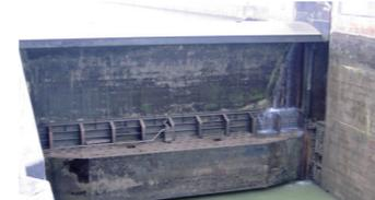
**Unterhaupt** Torkonstruktion am stromabwärtigen Ende der Schleuse
