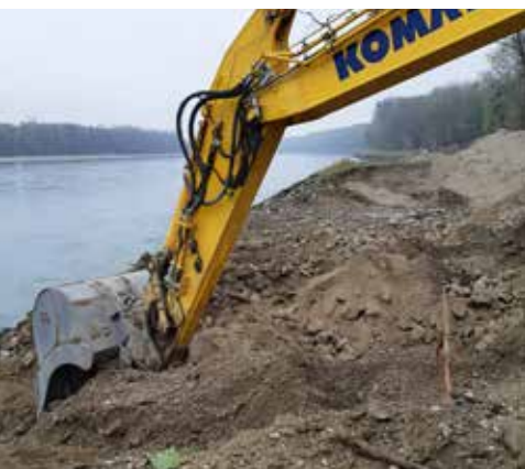
14 Umwelt Uferrückbau an der Fischa
