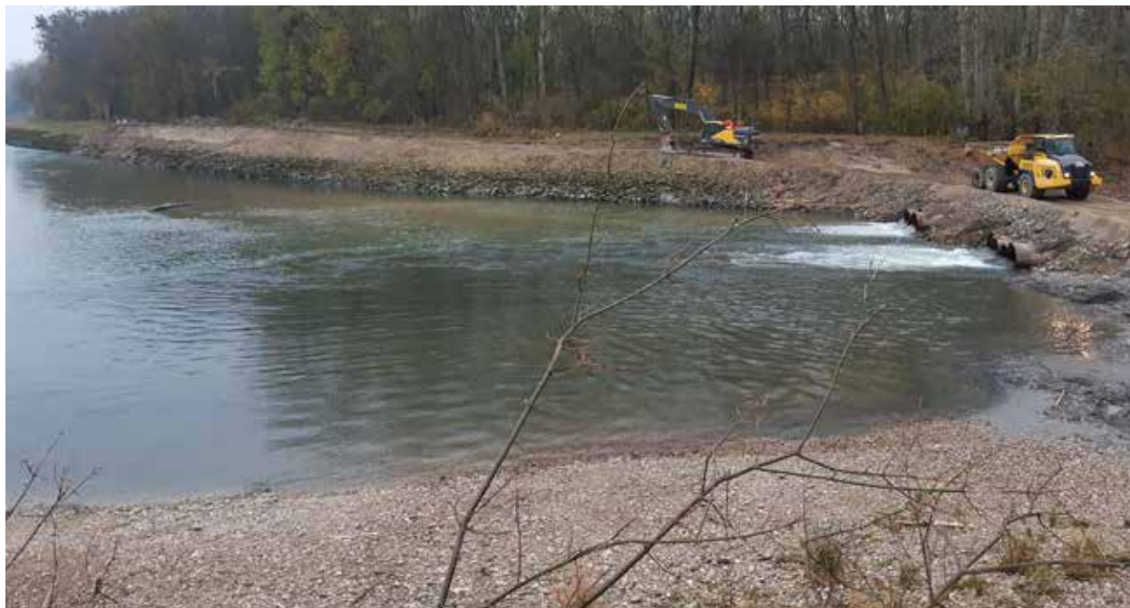
Zur Entfernung des harten Blockwurfes an der Fischamündung gehen kräftige Maschinen in Stellung.
