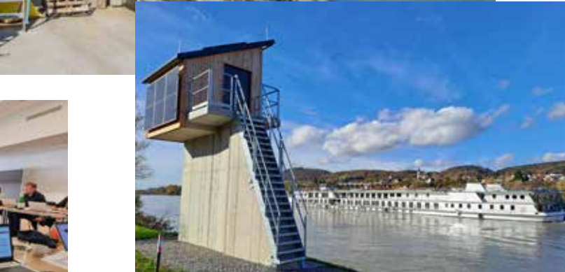
25 Stromkilometer 2035 Neues Pegelhaus wacht über Wachauer Donau
