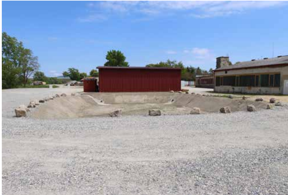
Einsatzsicherheit heißt auch gute Entwässerung. Dafür sorgen großdimensionierte Sickerbecken.
