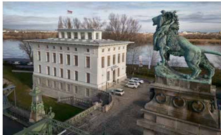
Otto Wagners Architektur-Kleinod am Brigittenauser Sporn. Nach intensiver historischer Analyse wurde der Originalzustand des ehemaligen Schleusengebäudes wiederhergestellt.
