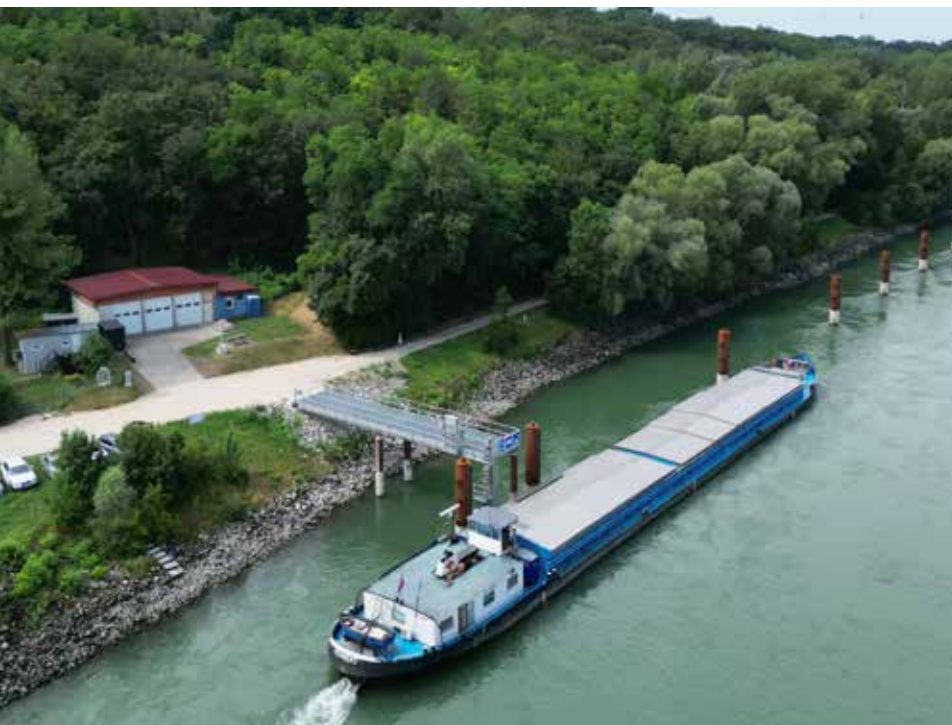
Modern ausgestattet und landstromversorgt. Mit neuen und aufgewerteten Liegestellen in Linz, Wien und Wildungsmauer setzte „FAIRway works! in the Rhine-Danube Corridor“ die Erfolgsgeschichte fort.
