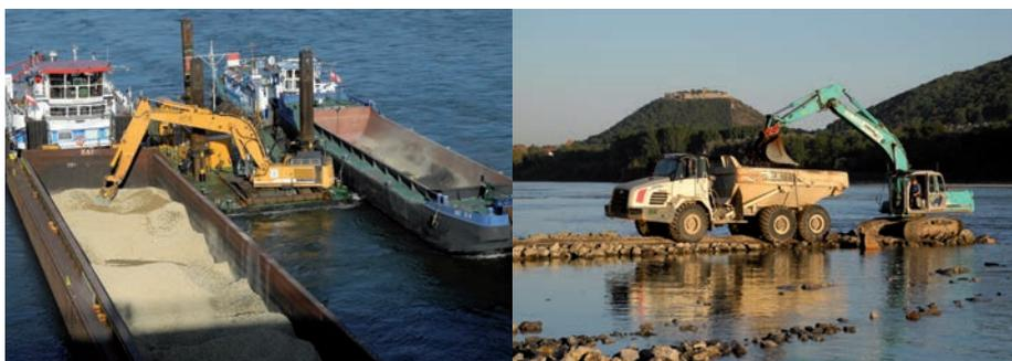
Beladung einer Klappschute mit Grobkies; Umbau einer Buhne
