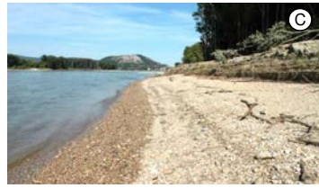
C Uferrückbau 1,4 km Abtrag der Steinsicherungen
