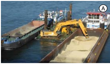
A Sohlanpassung u. Granulometrische Sohlverbesserung – Erprobung der Einbaumethode – rd 130.000 m 3 Kies
