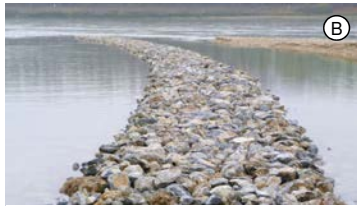
B Bühnenoptimierung – Neubau bzw. Umbau (19 Abtrag, 10 Neubau) Absenkung an der Bühnenwurzel
