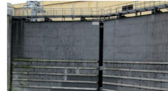
**Stemmtor** Schleusentor im Unterhaupt – Öffnung durch Aufschwenken
