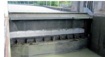
**Unterhaupt** Torkonstruktion am stromabwärtigen Ende der Schleuse
